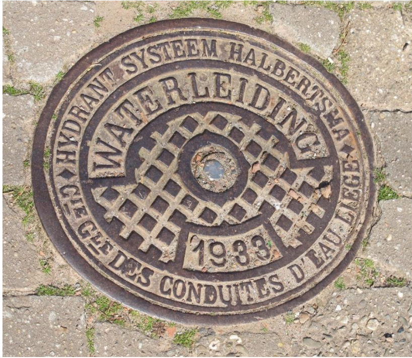
Putdeksel van de Compagnie Générale des Conduites d'Eau, voor Velperweg 145a.
